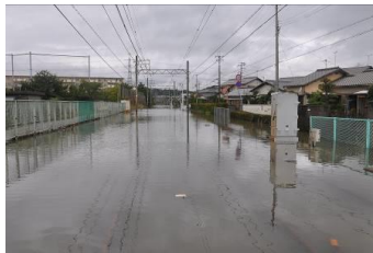
山陽電鉄軌道敷浸水状況（H23.9）
