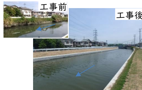
河川改修の状況（松陽橋下流）
